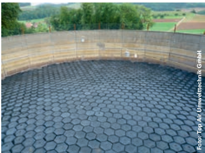
Das Güllesilo, nachdem es mit Matrix Cover® abgedeckt wurde.
